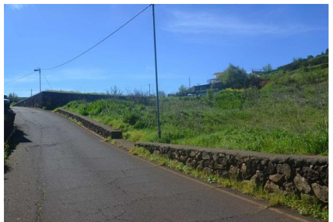
Blick nach Südwesten
