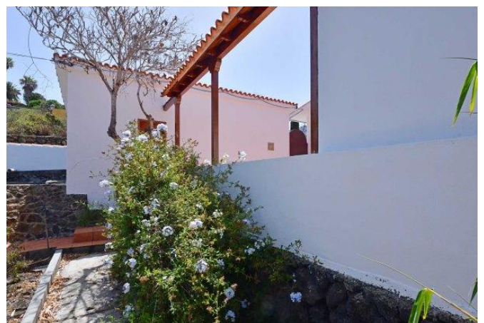
Innenhof, Garagengebäude mit Tür zum Schlafzimmer 2
