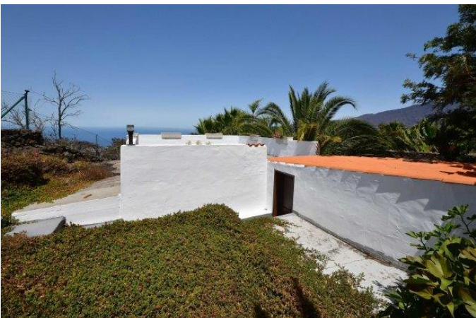
Reservewassertank mit Terrasse und Technikraum
