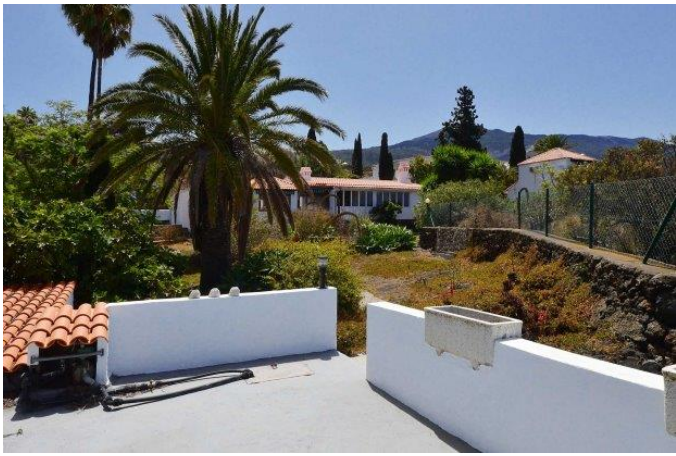
Blick von Terrasse Reservetank auf Wohnhaus
