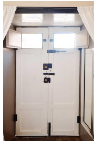
EG Wohnküche, historische Eingangstüre
