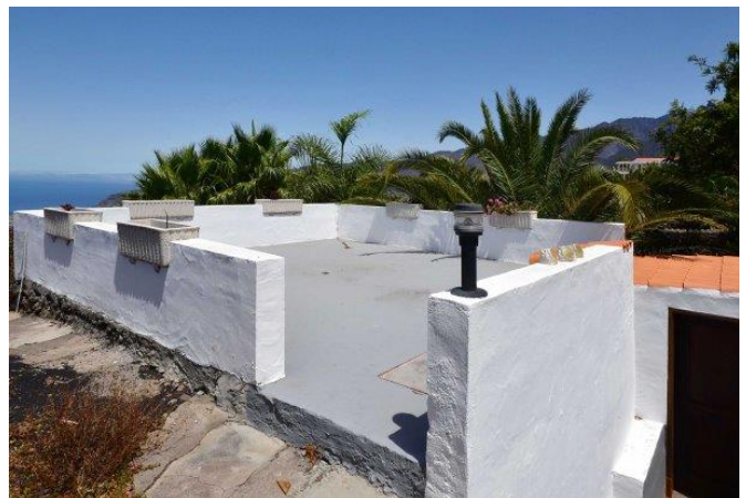
Reservewassertank mit Terrasse und Technikraum
