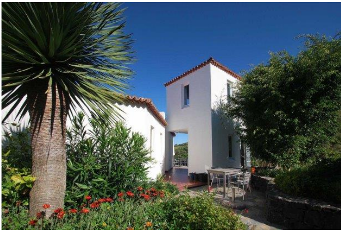
Ansicht Turmzimmer von Süden
