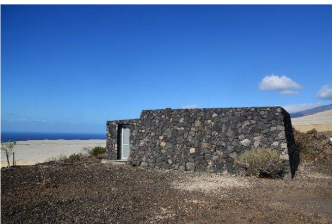
Eigener Wassertank mit Technikraum
