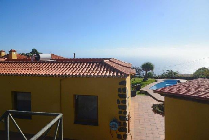
Ansicht von Westen, freier Zugang rund um das Haus
