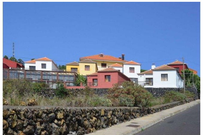
Ansicht der gesamten Anlage, bestehend aus 9 Apartmenthäusern
